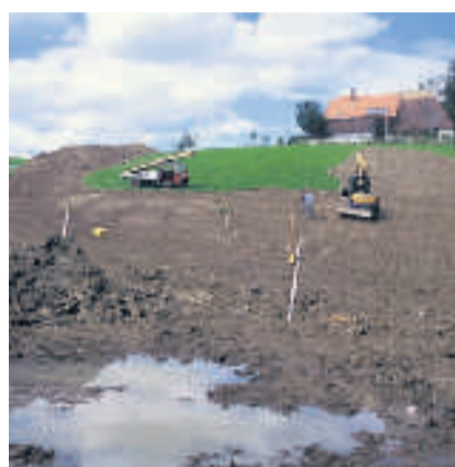
Der eigentliche Baubeginn nach dem Abhumusieren. MST
