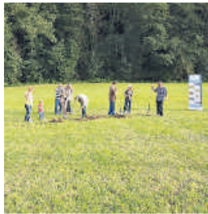
Start zur Umgestaltung: Spatenstich am 1. September. BT
